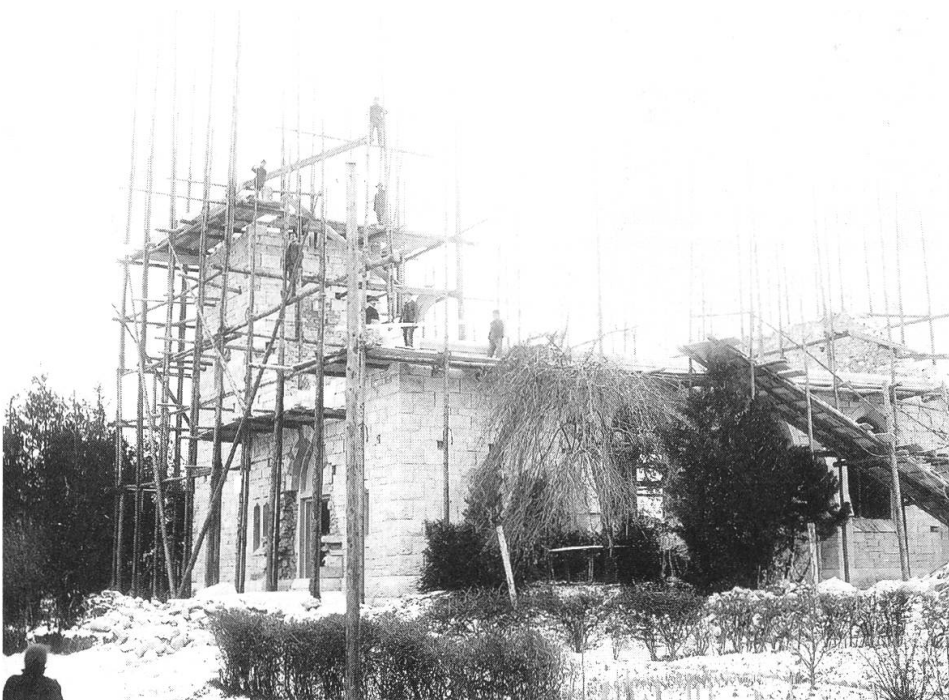
Die Kirche im Bau, um 1900. Foto: J. Lüthy, Eigentum HU. Meyer
