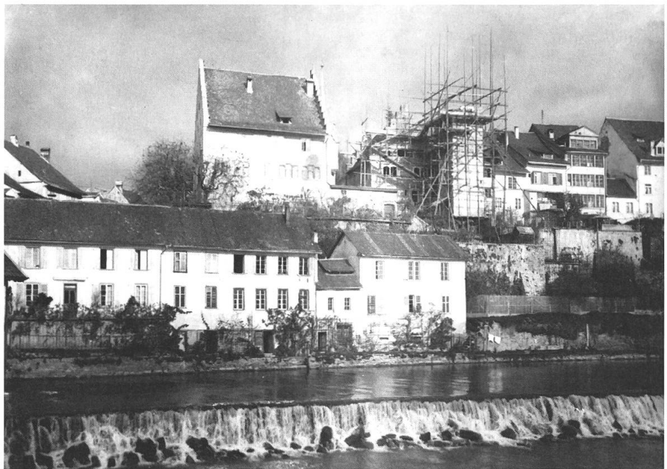
Der Turm wächst in die Höhe. Im November 1899 ...
