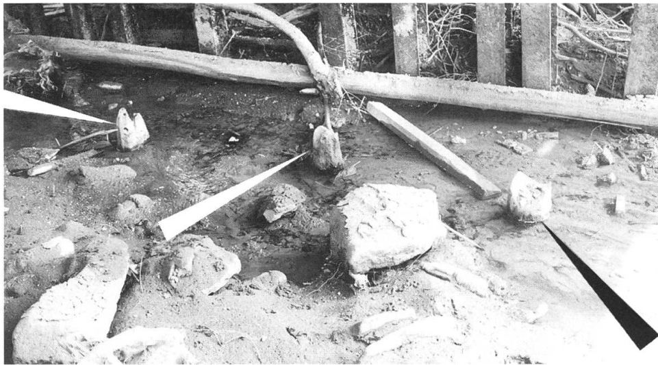
Abb. 3: Das Brückenjoch der Vorbrücke mit den Eisenpfählen.
