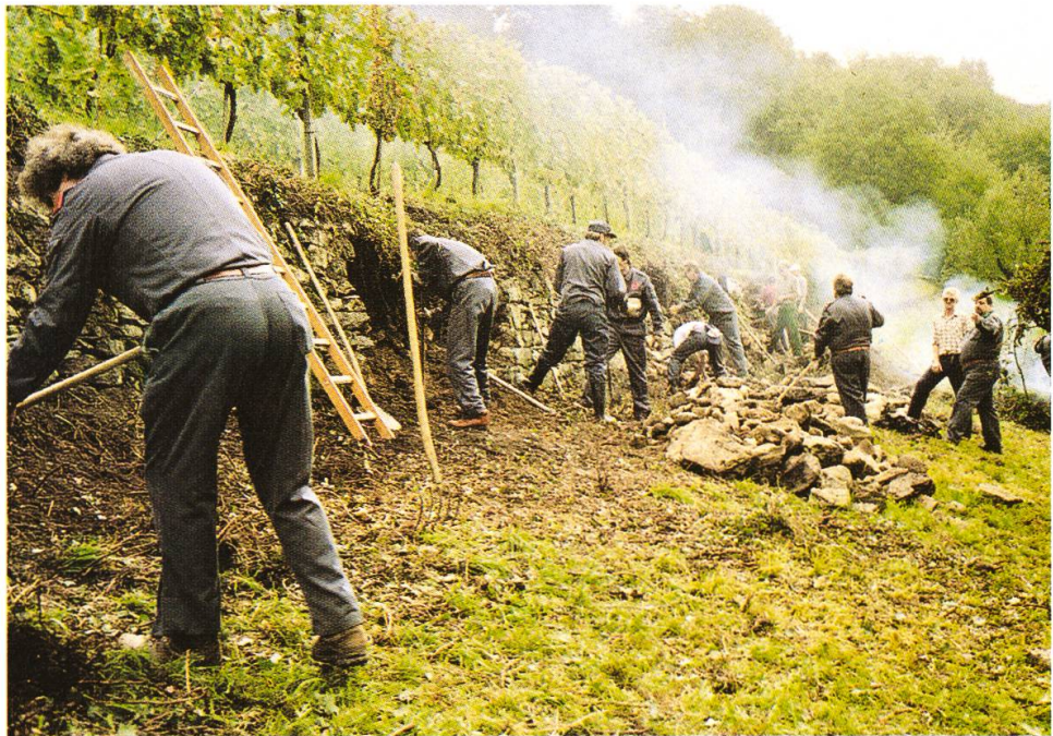
Abb. 16 – 19: Zivilschützer (ZSO Rohrdorf) beim Entmörteln bzw. Wiederaufbau historischer Reb- mauern im «Märxli» Oberrohrdorf
