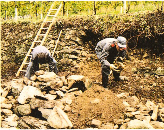
Abb. 16 – 19: Zivilschützer (ZSO Rohrdorf) beim Entmörteln bzw. Wiederaufbau historischer Reb- mauern im «Märxli» Oberrohrdorf
