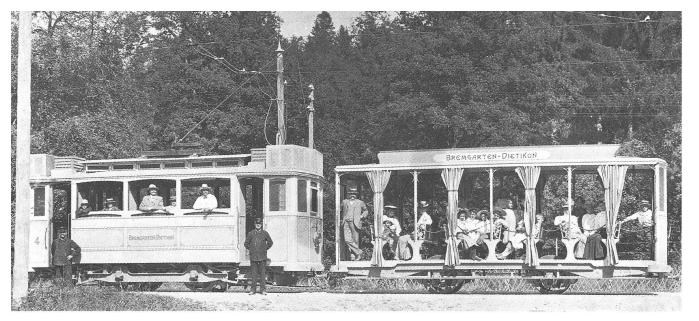
am 1. Mai 1902 der Wagenpark um zwei Sommerwagen erweitert wurde. Das heisst, es wurden keine neuen Verkehrsmittel hinzugekauft, sondern man baute 1904 die beiden Personenwagen C 4 und C 5 (Baujahr 1902) zu den Triebwagen Ce 2/2 4 und Ce 2/2 5 um. Die Untergestelle der beiden vorgängig erwähnten Triebwagen wurden durch die Schweiz. Wagonfabrik Schlieren (SWS) für den Aufbau der Sommerwagen C 11 und C 12 verwendet, welche 1929 zu C 13 und C 14 umnummeriert wurden.
