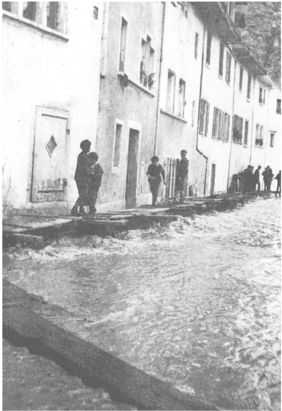
Die untere Reussgasse 1910 mit dem erstellten Notsteg.
