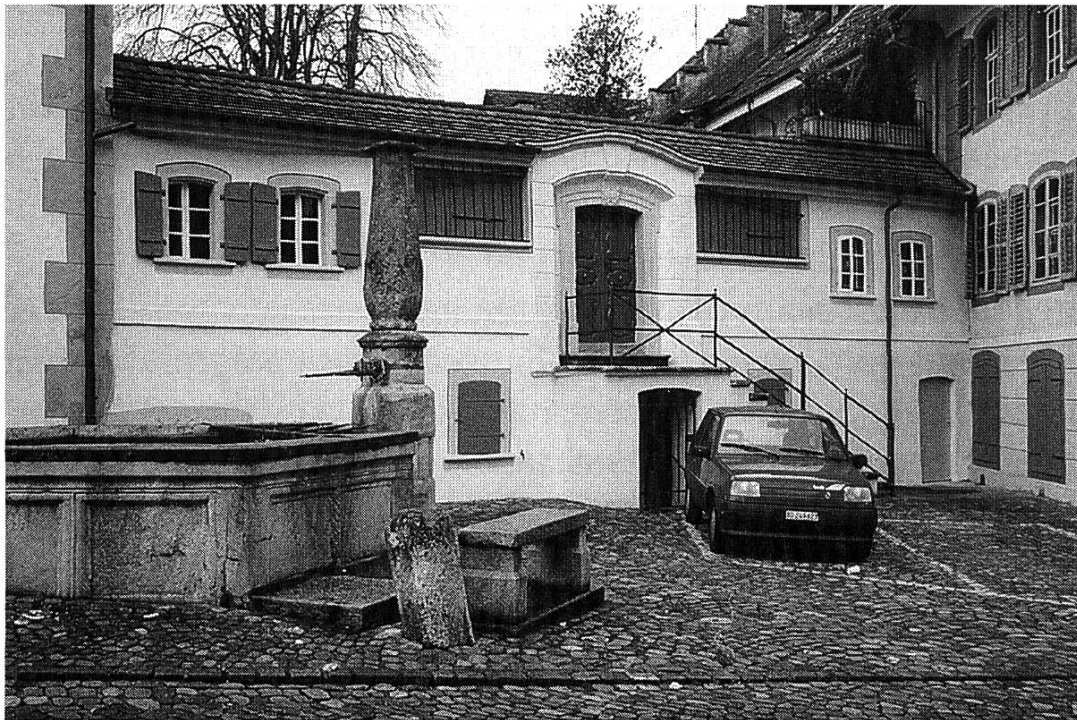
Teilansicht von der Gasse nach der Restaurierung.
