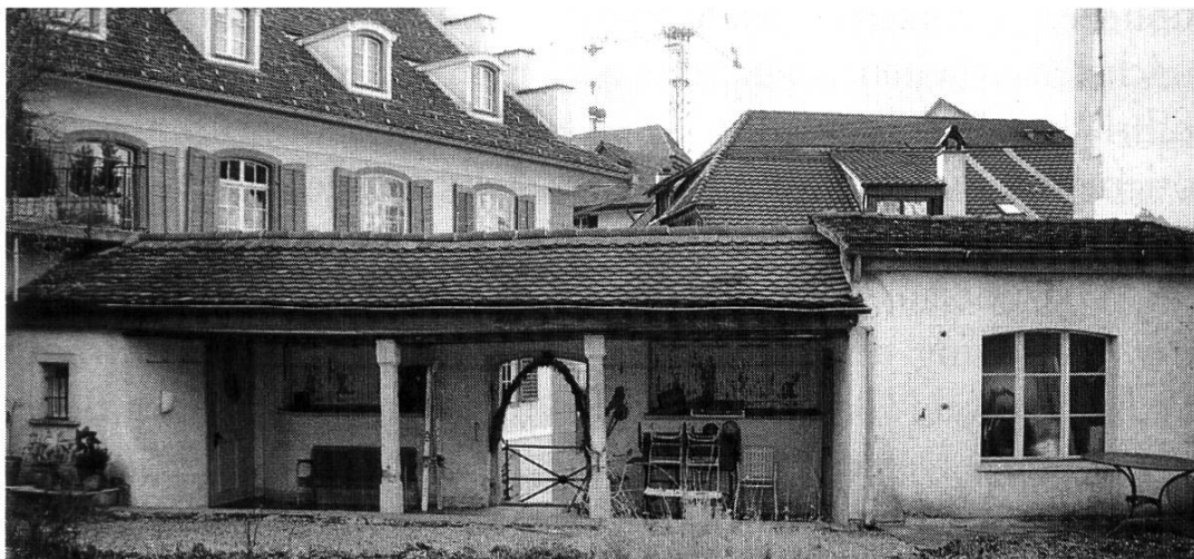
Gesamtansicht vom Garten vor der Restaurierung.
