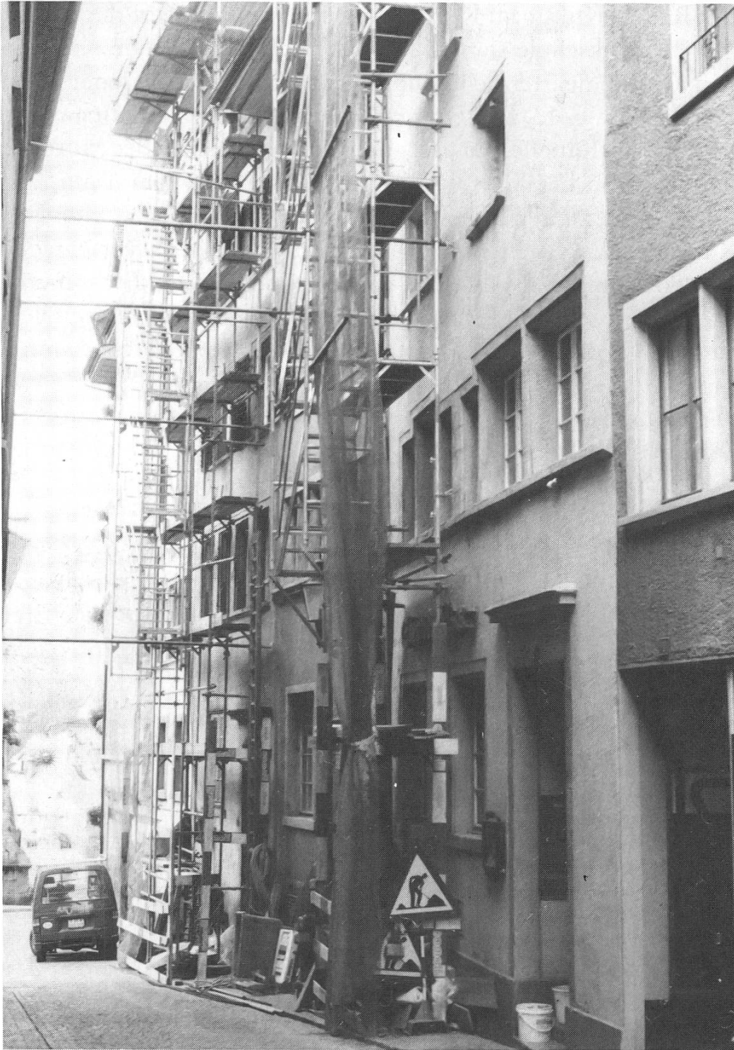
In den engen Gassen (das Bild zeigt die Sternengasse) sind Bauinstallationen nicht immer einfach zu errichten.
