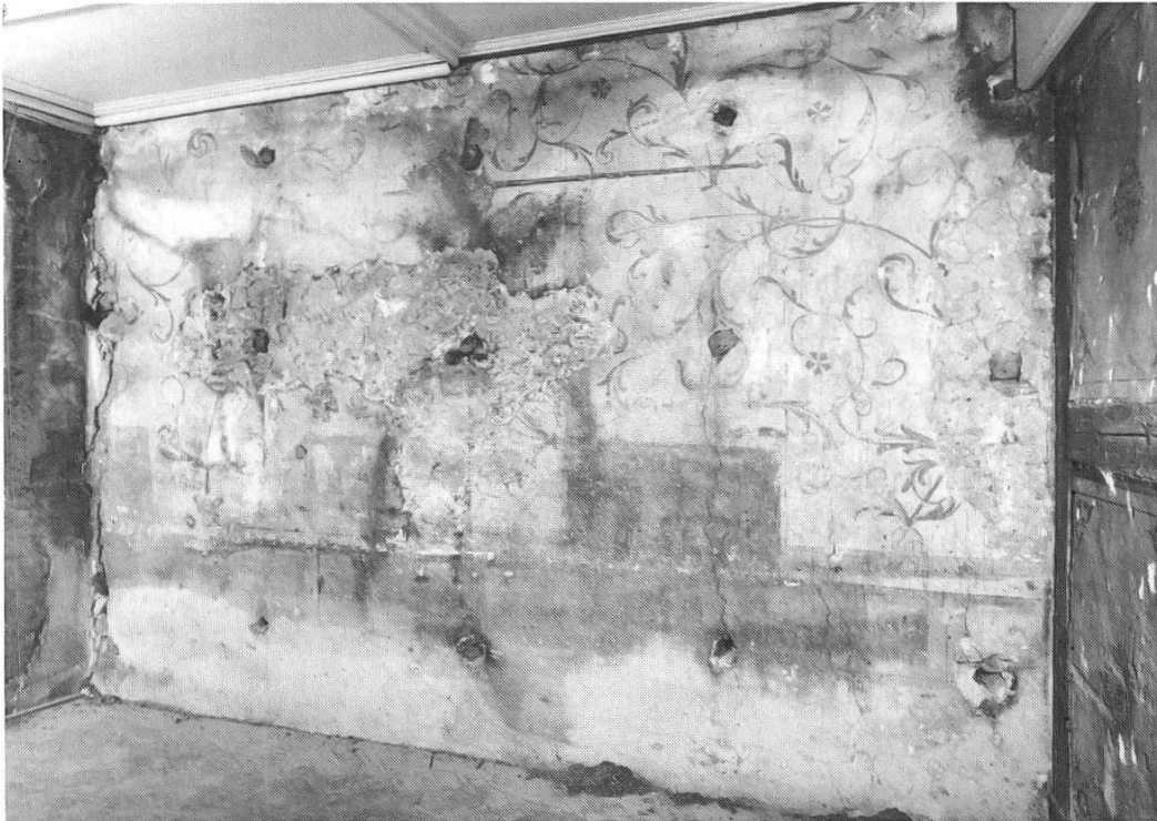
Im Gebäude Reussgasse Nr. 17 sind im 1. Obergeschoss an der Brandmauer zum Haus Nr. 19 bei Renovationsarbeiten reiche Wandmalereien freigelegt worden. Foto: Kant. Denkmalpflege
