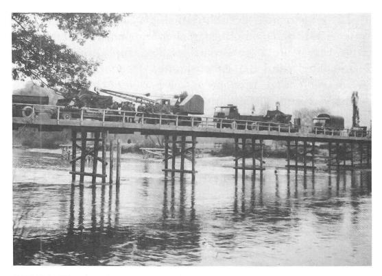
DIN-Behelfsbrücken 20 t, mussten während Jahren als Reussübergang Au—Fohlenweide dienen. Hohe Vekehrsbelastung und Wasserströmung setzten dieser überwiegend mit Holz konstruierten Brückenart gehörig zu. Bis zur Inbetriebnahme der Betonbrücke musste der Übergang erneuert, die Tragfähigkeit mit gerade im Einsatz verwendeten Truppenfahrzeugen neu geprüft werden
