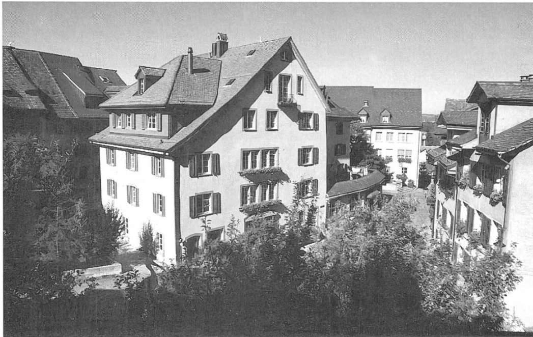
Das vor kurzem renovierte Streulihaus
