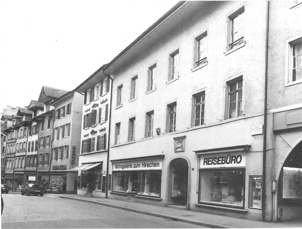
Die Gebäude der Marktgasse Nr. 21 und Nr. 25 im Jahre 1992
