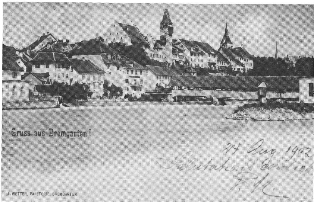
Die Reussfront mit Reussbrücke
