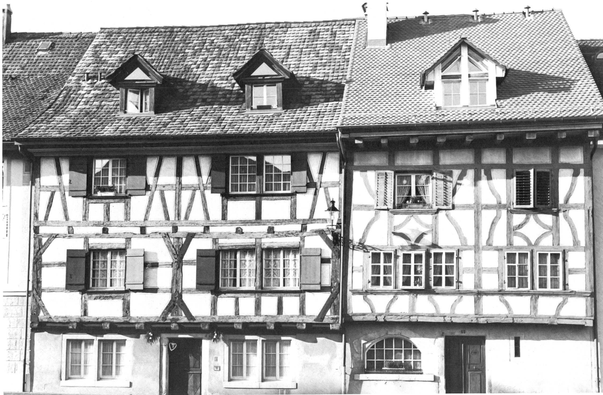
Riegelhäuser an der Schodolergasse mit erkerartig vorkragenden Obergeschossen.
