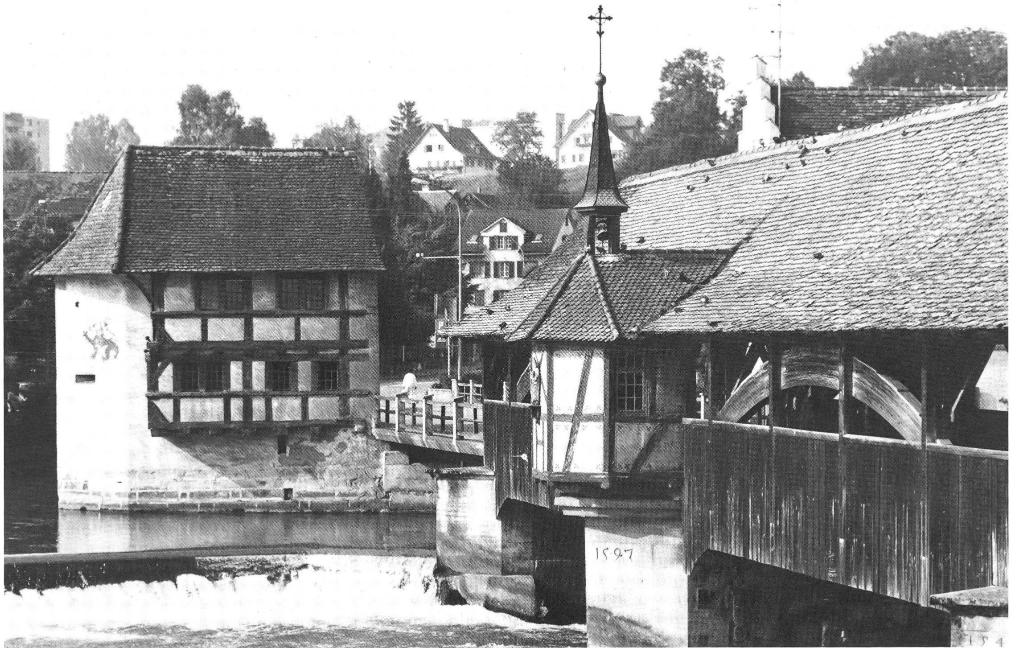
Gedekte Reussbrücke mit Agathakapelle und Bollhaus.
