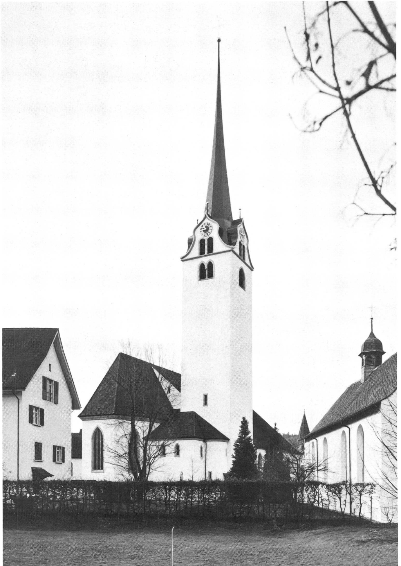
Neuerbaute Stadtkirche mit Klarakapelle (rechts) und Pfarrhaus (links), Blick von Nordosten.
