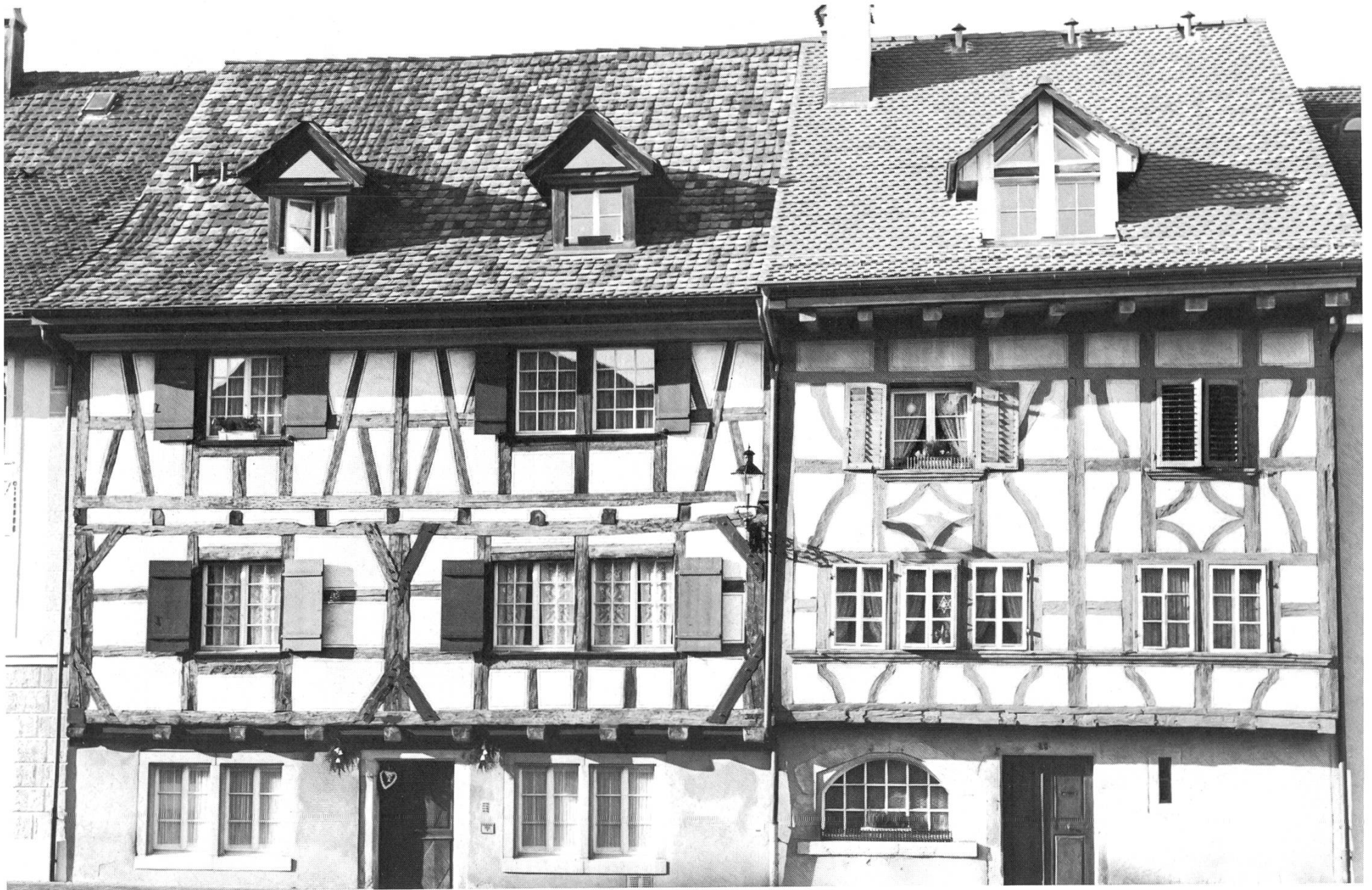
Riegelhäuser an der Schodolergasse mit erkerartig vorkragenden Obergeschossen.
