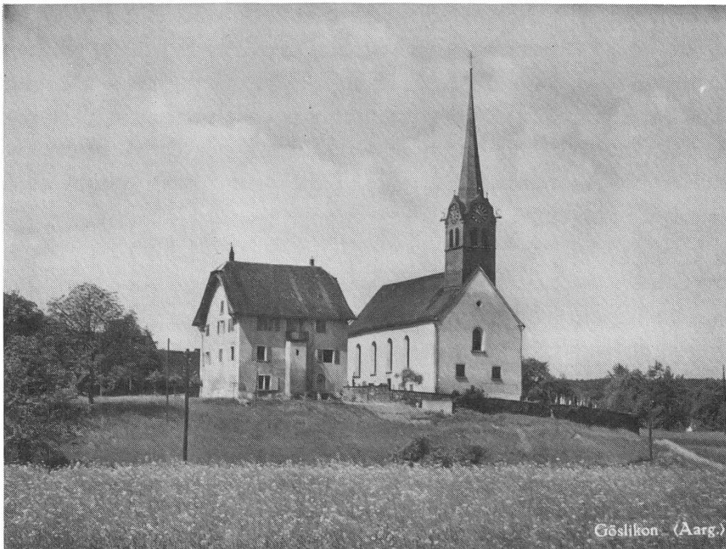
Kirche Göslikon, 1951, vor der Renovation
