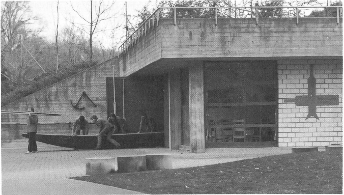
Neues Bootshaus in Fronarbeit erbaut 1974
