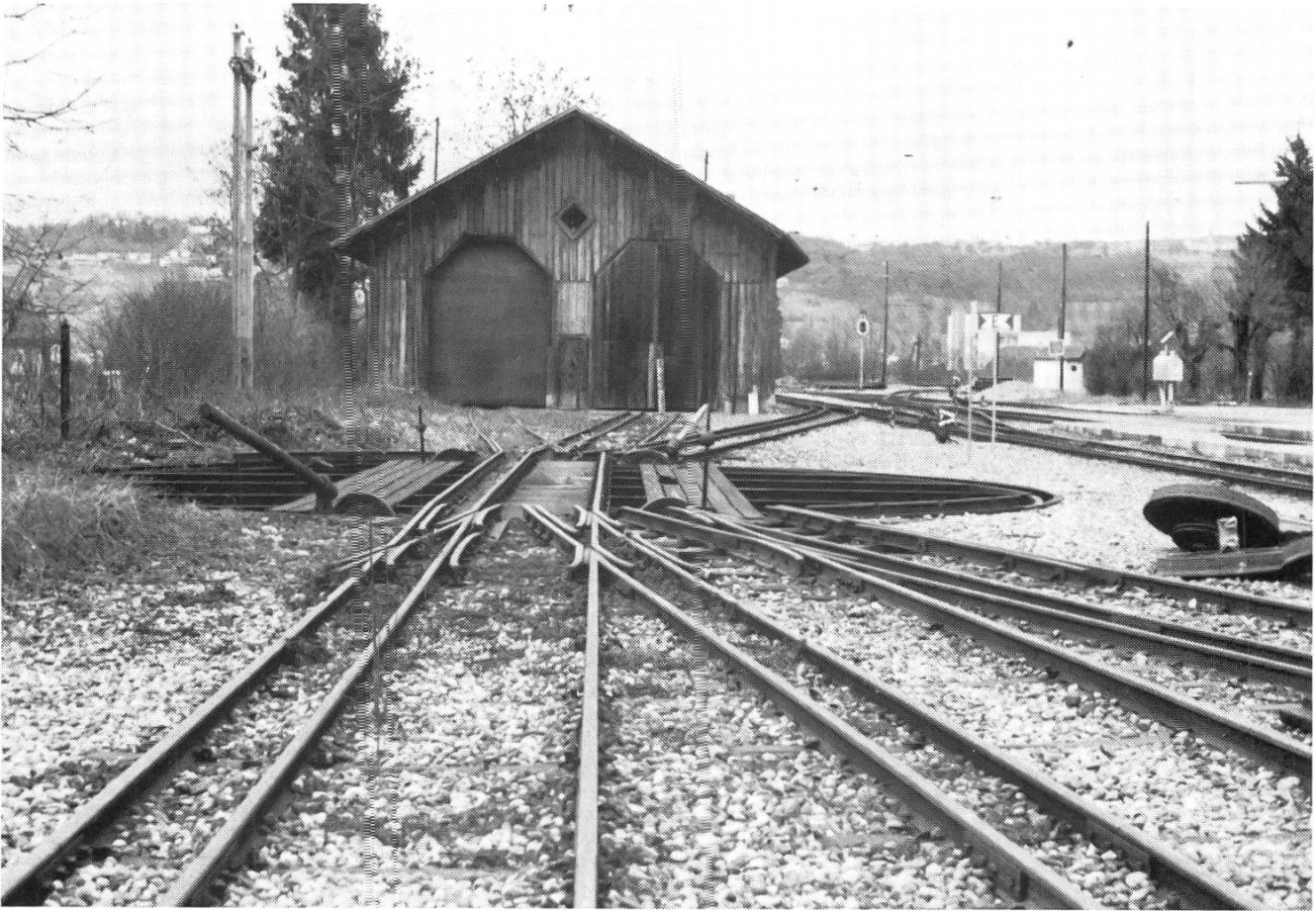
Alte Lok-Remise mit Drehscheibe
