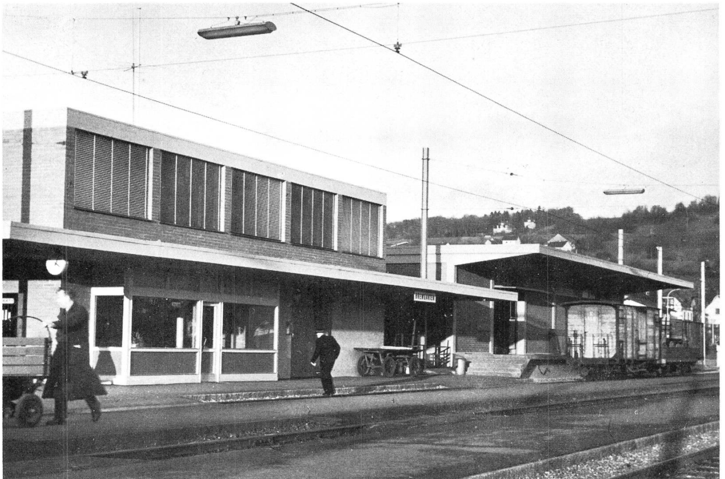
Neuer Bahnhof 1959 (Foto Lüthy)
