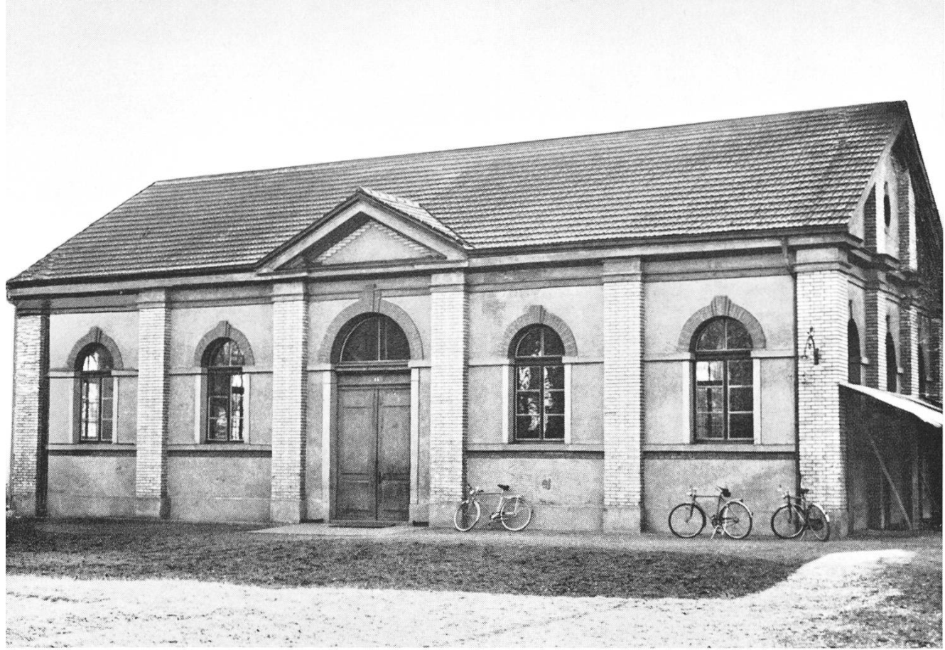
Die alte Turnhalle unmittelbar vor dem Abbruch (Ende April 1962)
