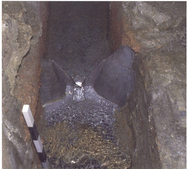
Abbildung 2: Die römische Wasserleitung speist bis heute den um 1872 gebauten Springbrunnen vor dem Hauptgebäude der Klinik Königsfelden (Bild: J. Trumm)
