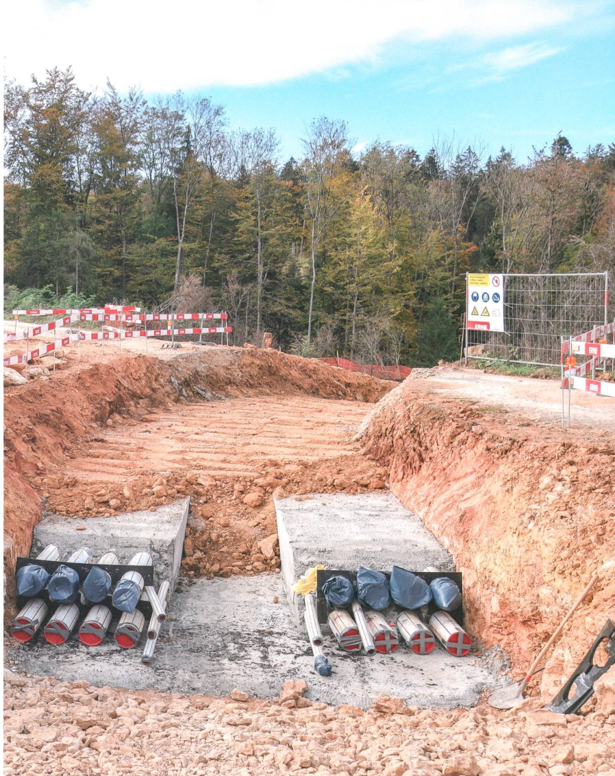
Betonierte Kabelkanäle (Bilder: Swissgrid)
