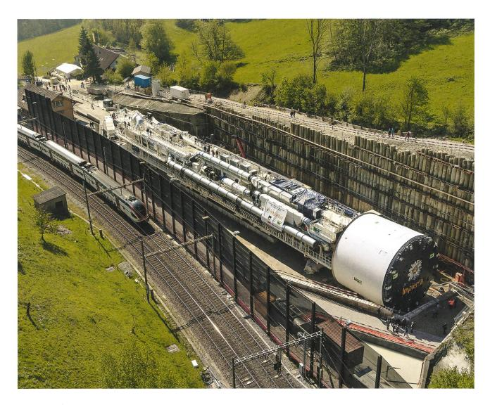
verlaufen. Mit 2693 Metern wird er um 167 Meter länger sein als der heutige Tunnel, der 1875 in Betrieb genommen worden war. Im Gegensatz zum alten Tunnel, der ein Hufeisenprofil aufweist, erhält der neue Tunnel ein kreisrundes Profil. Entsprechend dem Arbeitsdurchmesser der Bohrmaschine beträgt der Aussendurchmesser des Tunnels 12,4 m.
