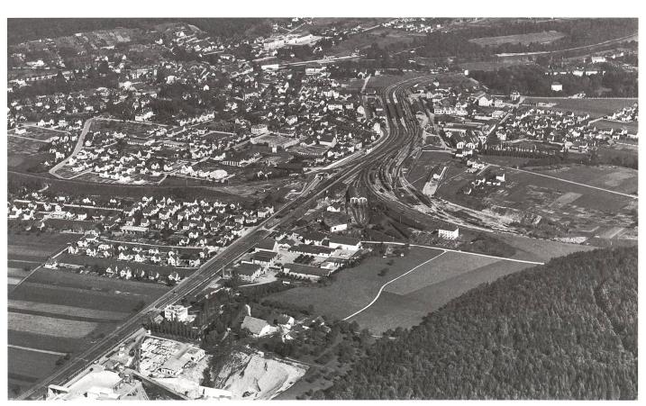
Auf diesem Bild von 1937 sieht man das 1921 neu erbaute Bahnhofgebäude mit den 1934 erstellten Perronanlagen. Die Unterführungen Zürcherstrasse (erbaut 1927) und Aarauerstrasse sind ebenfalls gut erkennbar. Die Fahrleitungsmasten wurden bei der Elektrifizierung von 1925 bis 1927 erstellt, daher rechts auch das grosse helle Unterwerkgebäude, wo die Bahnstromverteilung in unserer Region stattfand. Die Elektrifizierung machte die grossen Kohlenlager überflüssig, deshalb wurden sie abgebaut.
