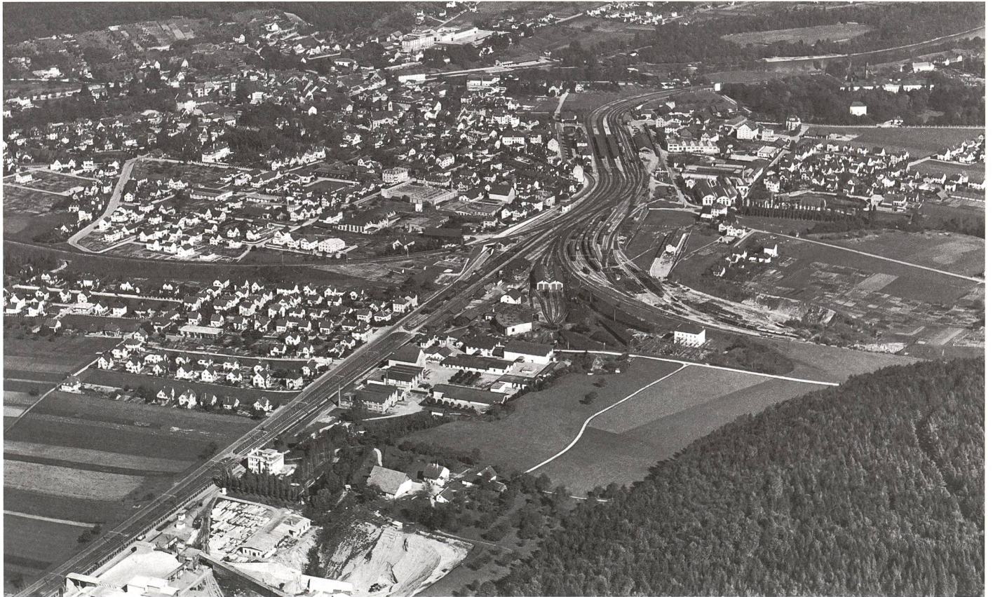
Auf diesem Bild von 1937 sieht man das 1921 neu erbaute Bahnhofgebäude mit den 1934 erstellten Perronanlagen. Die Unterführungen Zürcherstrasse (erbaut 1927) und Aaraustrasse sind ebenfalls gut erkennbar. Die Fahrleitungsmasten wurden bei der Elektrifizierung von 1925 bis 1927 erstellt, daher rechts auch das grosse helle Unterwerkgebäude, wo die Bahnstromverteilung in unserer Region stattfand. Die Elektrifizierung machte die grossen Kohlenlager überflüssig, deshalb wurden sie abgebaut.
