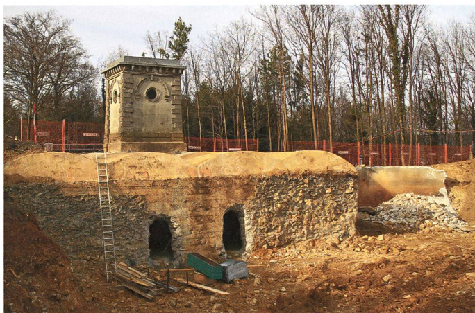
Februar 2010: Das freigelegte Windischer Wasserreservoir Chapf mit dem 112-jährigen Turm ist schützenswert
