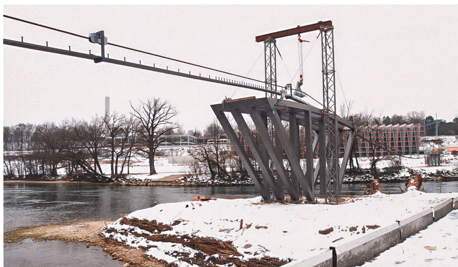
März 2010: Das erste Spannband des Fussgängerstegs Schachen-Mülilmatt wird über die Aare gezogen Foto: Walter Schwager, Aargauer Zeitung
