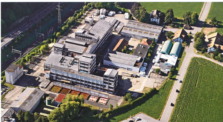
August 2010: Ein letztes Mal vor Abbruchbeginn sticht der Fabrikkomplex der Reichhold Chemie ins Auge Foto: Peter Belart, Aargauer Zeitung
