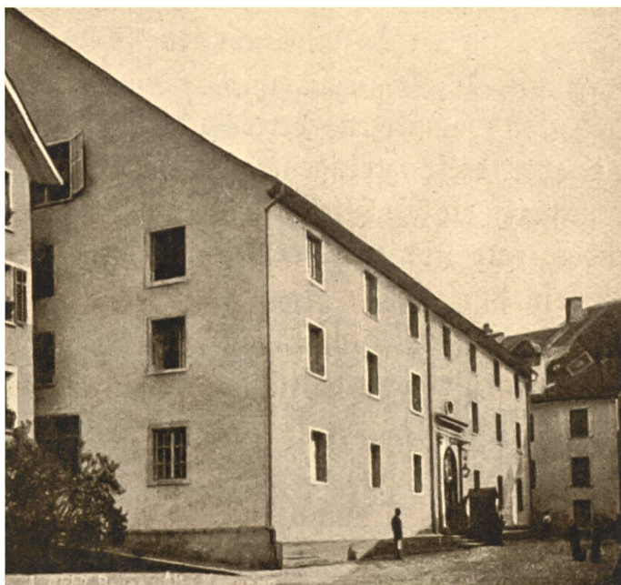
Das ehemalige Kornhaus vor und nach dem Umbau von 1927. Die zweiteiligen Rechteckfenster im Erdgeschoss wurden durch grosse Rundbogenschaufenster, jene im ersten Stock durch breitere dreiteilige Rechteckfenster ersetzt. Die Fenster im zweiten Stock sowie auf der Giebelseite blieben in der Originalgrösse bestehen. Ursprünglich mit Treppengiebeln
