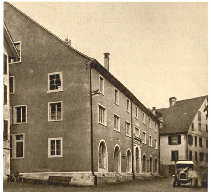
Das ehemalige Kornhaus vor und nach dem Umbau von 1927. Die zweiteiligen Rechteckfenster im Erdgeschoss wurden durch grosse Rundbogenschaufenster, jene im ersten Stock durch breitere dreiteilige Rechteckfenster ersetzt. Die Fenster im zweiten Stock sowie auf der Giebelseite blieben in der Originalgrösse bestehen. Ursprünglich mit Treppengiebeln
