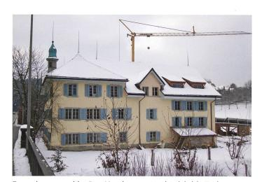
Fassade reussseitig. Der Kernbau erstreckt sich bis Ende Giebellukarne. Rechts davon das umgebaute Ökonomiegebäude mit versetztem Stockwerk wegen des über das Terrain ragenden hohen Kellerscheitels
