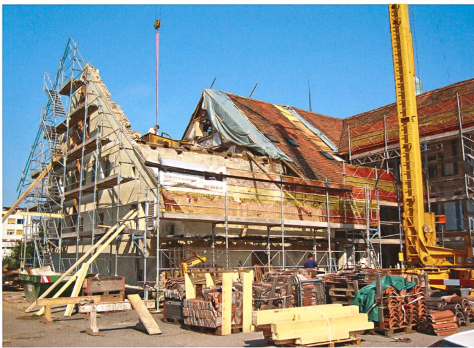
Entfernen des Dachstocks über dem ehemaligen Ökonomierteil
