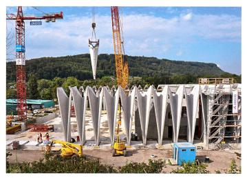
Der 500-Tonnen-Raupenkran platziert Betonelemente bis zu 50 Tonnen
