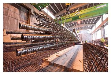
Produktion der Armierung für die Dachträger
