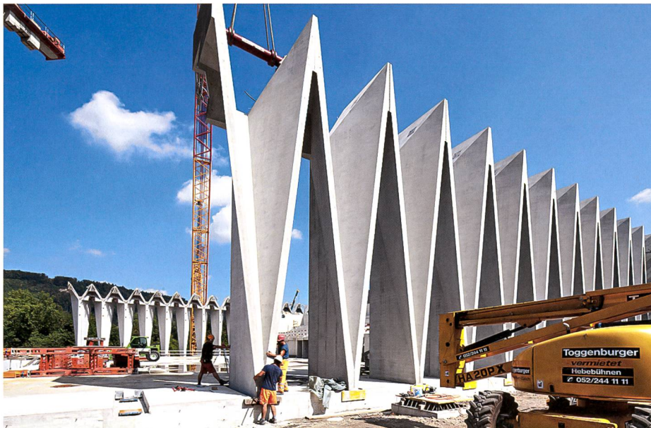
Die Versetzung der Fassadenelemente
