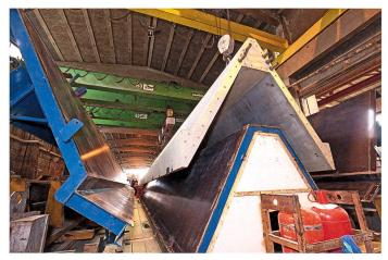
Ein Dachträger wird aus der Schalung gehoben
