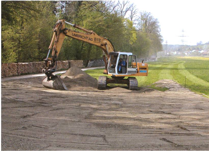
Deponie in Riniken: Schutz der Ackerfläche durch Kiessvorlage
