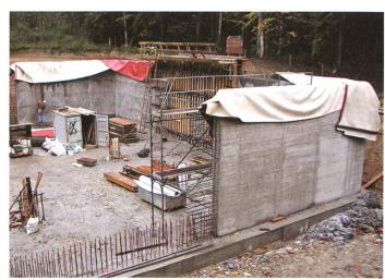
Betonieren der Wände des neuen Reservoirs
