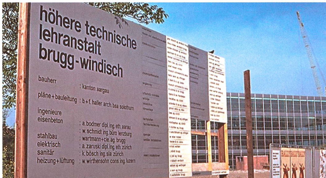
Professor Fritz Haller entwarf das Gebäude für die HTL: ein ambitionöses Vorhaben.
