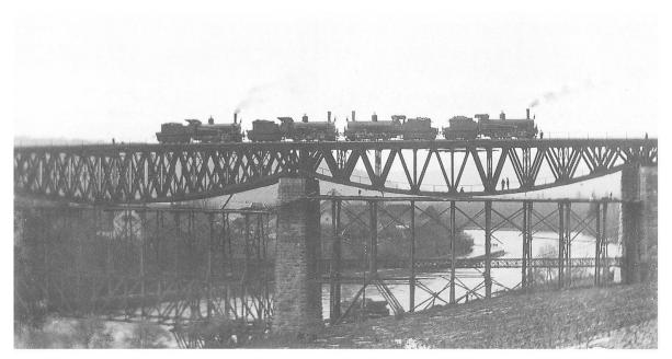
Die Belastungsprobe für die neue Eisenbahnbrücke gelingt. (vgl. «Brugger Neujahrsblätter» 106 (1996) 111–132)
