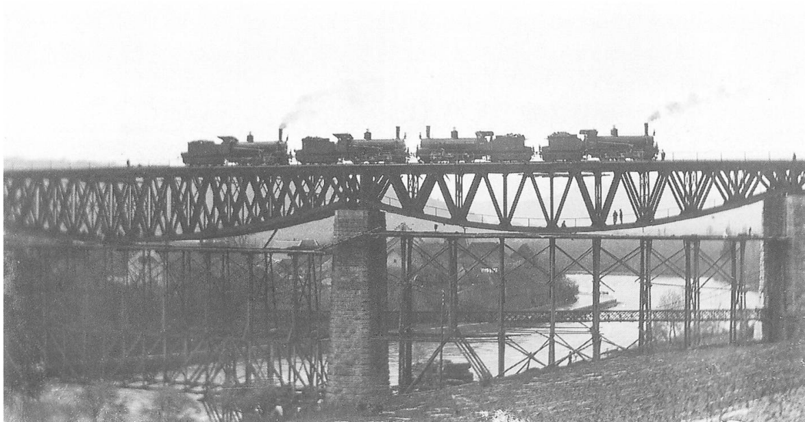
Die Belastungsprobe für die neue Eisenbahnbrücke gelingt. (vgl. «Brugger Neujaersblätter» 106 (1996) 111–132)
