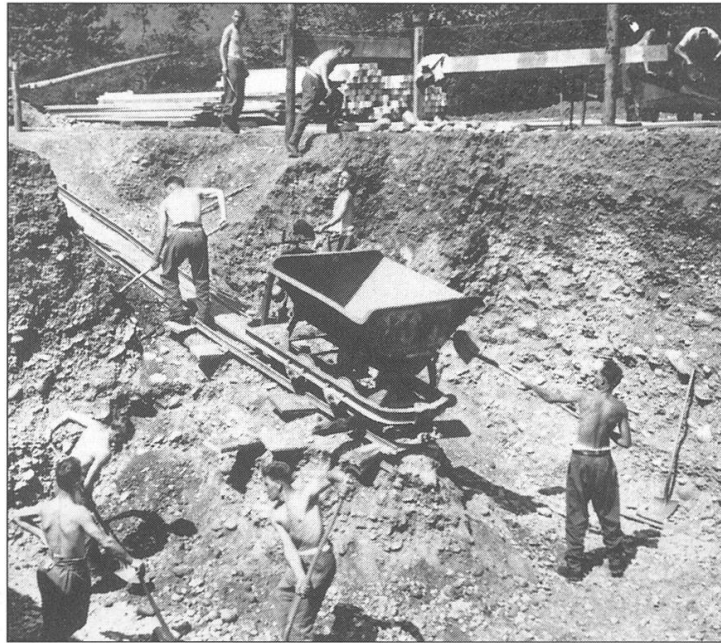
Abb. 5 Aushub im Kiesboden, etwa 200 m 3 (5000 Karretten).
