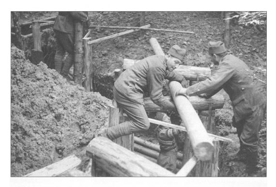
Abb. 1 Ein gewundener Verbindungsgraben wird überdeckt.
