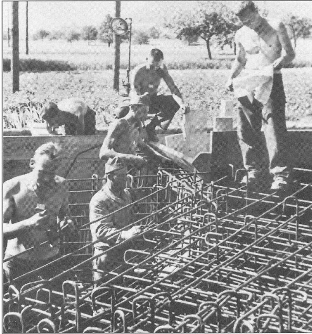
Abb. 7 Armierung der Decke, Dicke der Eisen 18 mm.
