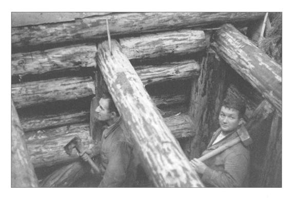
Abb. 3 Waffenstellung vor dem Einsetzen der Deckenbalken.
