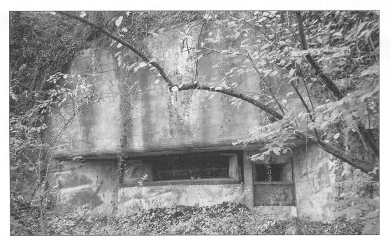
Abb. 21 Beobachterstand West mit Beobachter-Scharte, rechts kleine Blinker-Scharte zum Gegenwerk am Buck. Bild von 1999.
