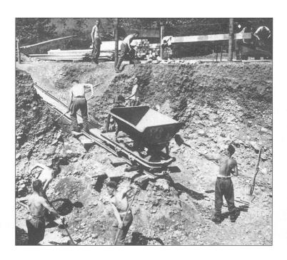
Abb. 5 Aushub im Kiesboden, etwa 200 m³ (5000 Karretten).
