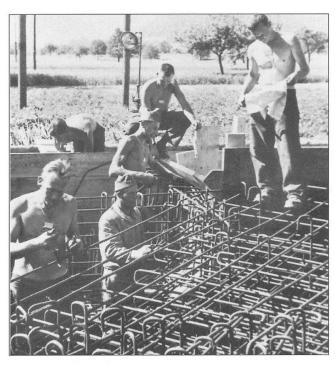
Abb. 7 Armierung der Decke, Dicke der Eisen 18 mm.
