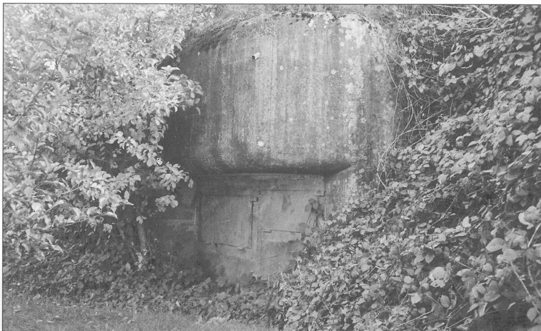
Abb. 15 Mg Bunker: Scharte links für die Waffe, rechts für den Beobachter (Nr. 38 auf der Karte 30).
