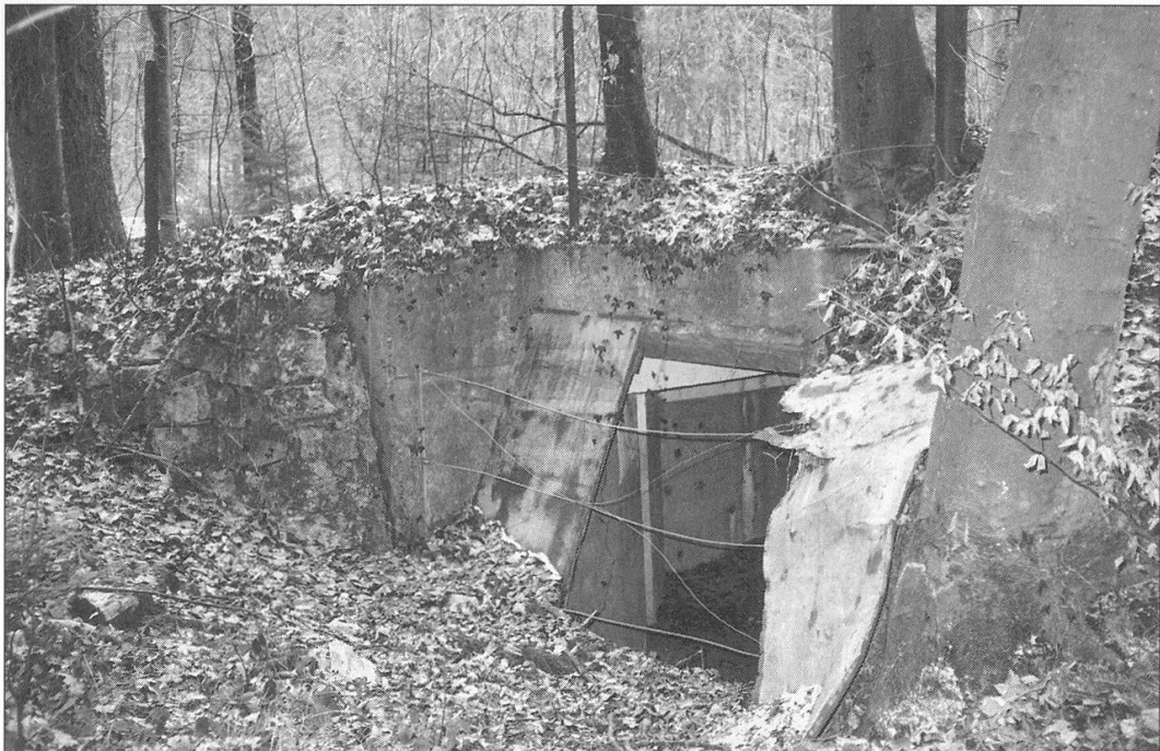
Abb. 18 Frontseite mit grosser Scharte für das Geschützrohr.
