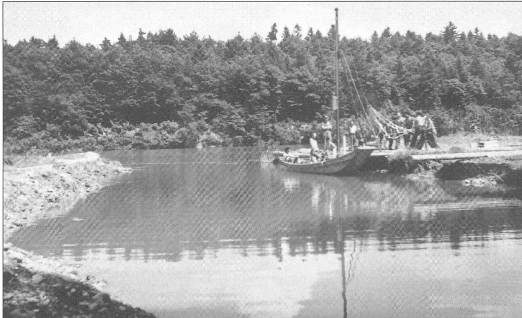
Abb. 9 Blick über die Bucht gegen die offene Aare. Füsiliere beim Rammen der Spundwand. Mai/Juni 1940.
