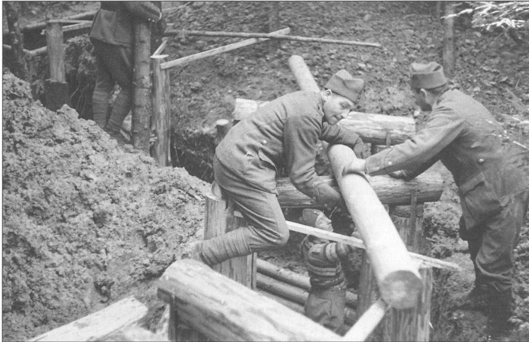
Abb. 1 Ein gewundener Verbindungsgraben wird überdeckt.
