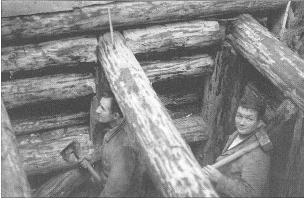
Abb. 3 Waffenstellung vor dem Einsetzen der Deckenbalken.
