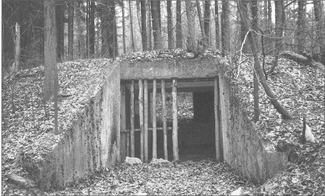
Abb. 17 Rückseite mit Einfahrt, berechnet für Kanone 10,5 cm.
