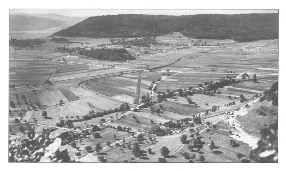
Abb. 12 Das Betonhöckerband vom Buck rechts unten über das Feld zum Fuss des Chabisbergs, dann nach links bis an die Aare. Bild vom Mai 1940.
