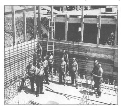
Abb. 6 Der Boden ist betoniert, die Armierung der Wände beginnt.
