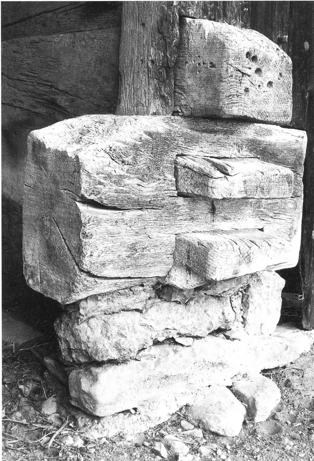
Eichenes Zapfenschloss des Schwellenbalkens auf niedriger Bruchsteinmauer.
