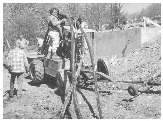
April 2000 – Rohre für Frischwasser, Strom und Telekommunikation für den Weiler Sennhütten werden in einem Arbeitsgang in den Boden eingepflügt. Damit wird der Weiler an die heutigen Infrastrukturwerke angeschlossen.
