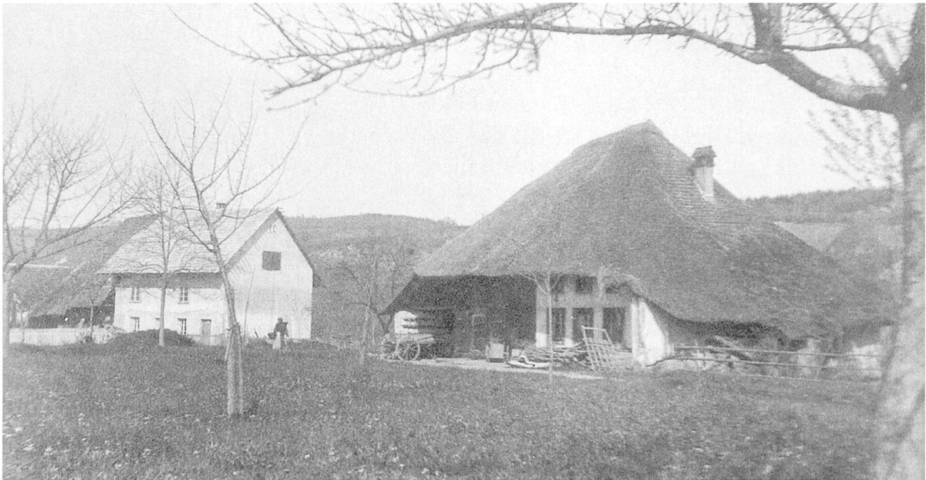
Zwei Generationen Altenburger Häuser: Rechts: Wohn- und Ökonomiegebäude aus Stein und Holz mit Strohdach (beim Kamin mit Ziegeln bedeckt). Links: Wohnhaus aus Stein mit Ziegeldach.
