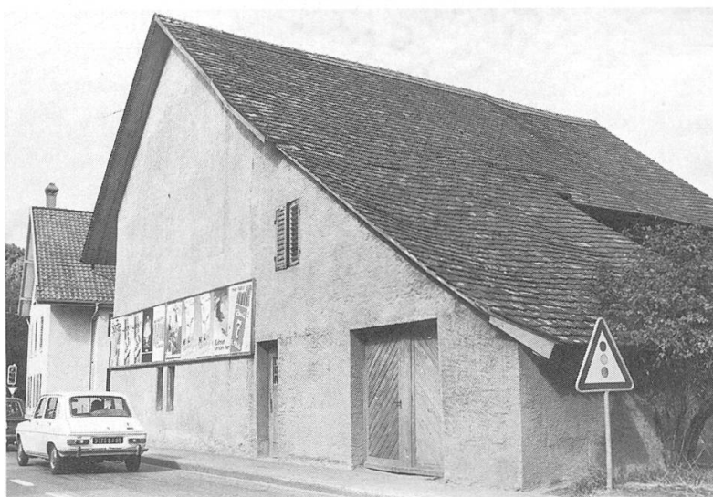
Blick von Süden, Front gegen die Hauserstrasse. Foto: Werner Keller
