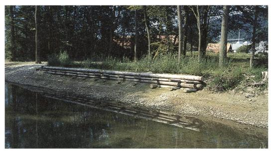
Die einzigen namhaften Uferverbauungen, die erstellt worden sind, sichern den Umgebungsbereich der Grundwasserpumpstation des Zeughauses Brugg. Das Forstamt Brugg hat dafür aus Baumstämmen blockhausartig zusammengefügte Holzkasten in alter Wasserbautradition gefertigt. Diese verhindern zum Schutz des Pumpwerks einen hier unerwünschten Uferabtrag. Sie bestehen aus unbehandeltem Rundholz, sind mit Kies gefüllt und weisen eine Fundationstiefe von einem Meter unter Sohlenniveau auf.
