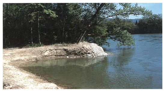
Drei Einbuchtungen an der Aare bieten dem Wasser neue Angriffsflächen zur Uferveränderung. Zudem wird das gerade und gleichförmig verlaufende Aareufer strukturell aufgewertet. Die alte Uferverbauung wurde entfernt; Stillwasserbereich, Zugänglichkeit für Biber, Brutwand für Eisvogel sind geschaffen.
