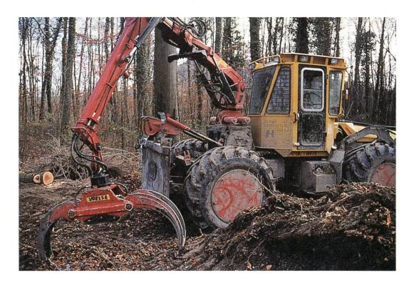
Als erstes erfolgt der Aushieb der Baufläche, bei dem rund 500 m³ Rundholz anfallen. Die Bäume werden zu den gängigen Holzsortimenten aufgerüstet und mittels Schlepper zu den Lagerplätzen entlang der Militärstrasse gerückt. Gut drei Viertel des Rundholzes gehen in den Verkauf. Ein Viertel wird für die Holzkastenverbauungen verwendet.
