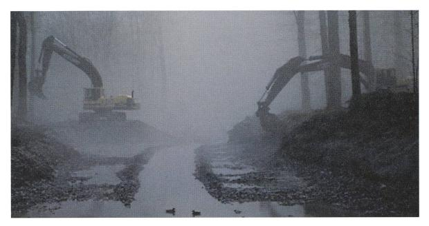
Der noch vorhandene Gerinnequerschnitt wird mit Baggereinsatz nur soweit ausgeweitet und abgetieft, dass der künftige Wasserabfluss genügend Schleppkraft für Tiefen- und Seitenerosion erhält. Die Uferböschungen im sandigen Boden vermögen dem Wasser verhältnismässig wenig Widerstand entgegenzusetzen.
