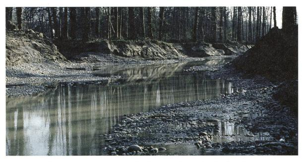
Die Linienführung des Seitenarmes ist leicht gewunden und gebuchtet. Im oberen Projektabschnitt verläuft die Sohle ganz im Kies. In der Sohlenmitte ermöglicht eine Niedrigwasserrinne, dass die Fische auch bei tiefem Wasserstand der Aare passieren können. An verschiedenen Stellen wurden sogar Vertiefungen («Überlebenslöcher») angelegt. Sie führen stets Wasser und bieten Rückzugsmöglichkeiten für Wassertiere.
