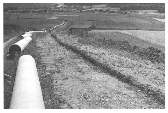
Bauarbeiten auf dem Gasleitungstrassee. Die Leitungsrohre sind bereits neben dem abhumusierten Trassee ausgelegt. Im Hintergrund Rüfenach und Hinterrein.
