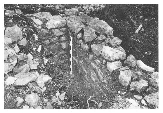
Die Südostecke von Gebäude III. Das Mauerwerk, das typisch ist für die Gebäude der Burg, besteht aus handquaderartigen Bruchsteinen in sorgfältig lagerhafter Schichtung.
