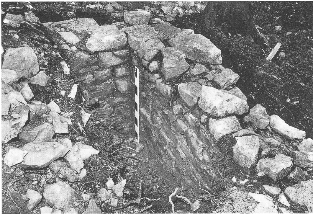
Die Südostecke von Gebäude III. Das Mauerwerk, das typisch ist für die Gebäude der Burg, besteht aus handquaderartigen Bruchsteinen in sorgfältig lagerhafter Schichtung.
