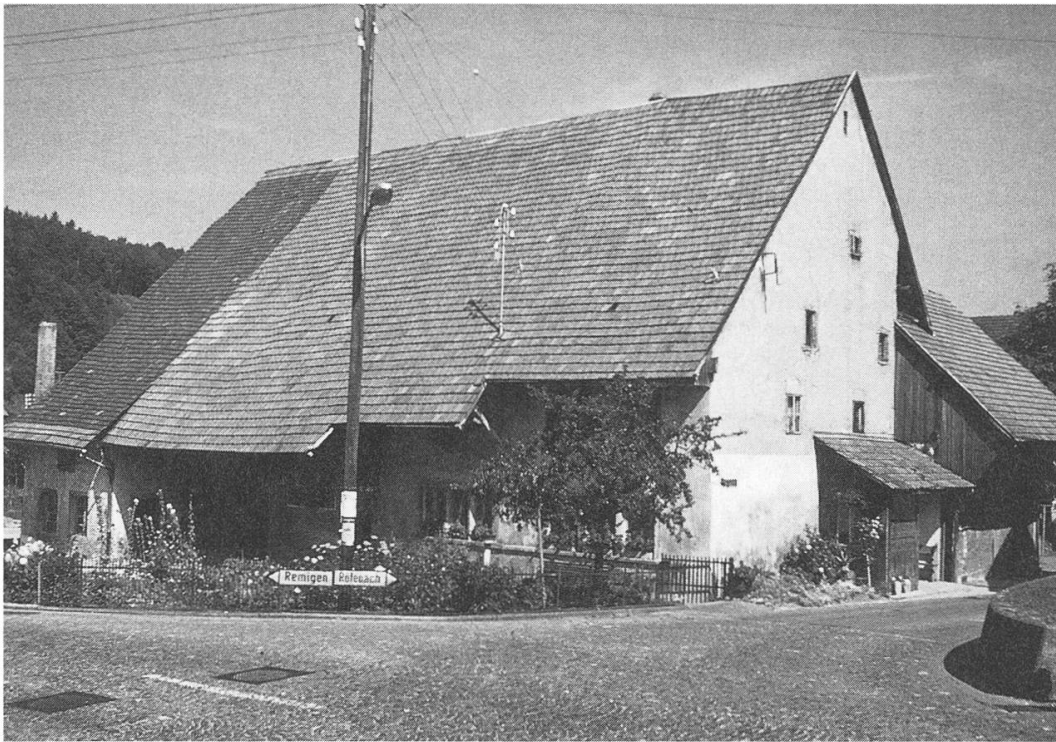
Das Märkihaus vor dem Abbruch des strassenseitigen Hausteils und vor der Renovation. Foto: Paul und Marie Schärer-Obrist
