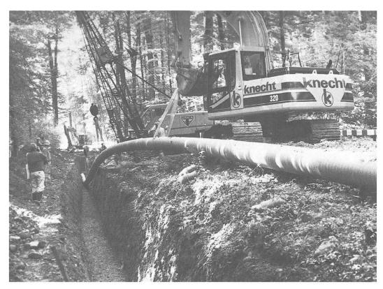
APRIL 1996 – Für das weltweit grösste, neue Gasturbinen-Prüfzentrum der ABB in Birr wird ein rund 120 m langes Teilstück der Gasleitung Othmarsingen–Birr in den vorbereiteten Graben gesenkt.
