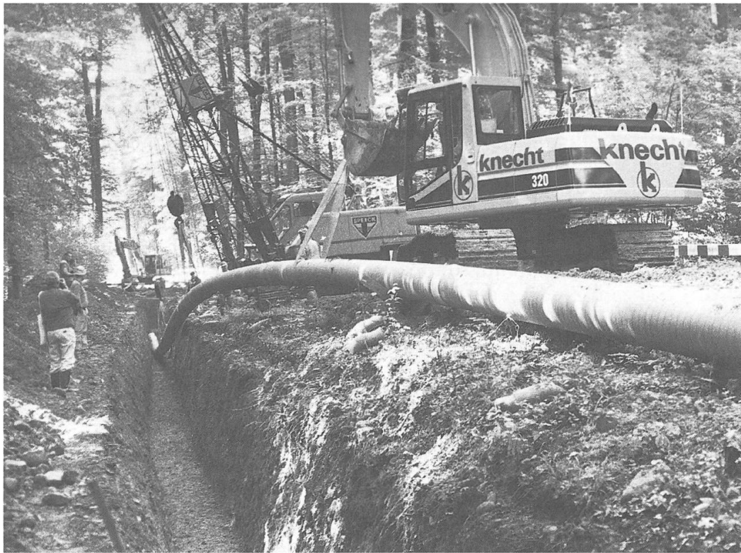
APRIL 1996 – Für das weltweit grösste, neue Gasturbinen-Prüfzentrum der ABB in Birr wird ein rund 120 m langes Teilstück der Gasleitung Othmarsingen–Birr in den vorbereiteten Graben gesenkt. Foto: Geri Hirt, Badener Tagblatt
