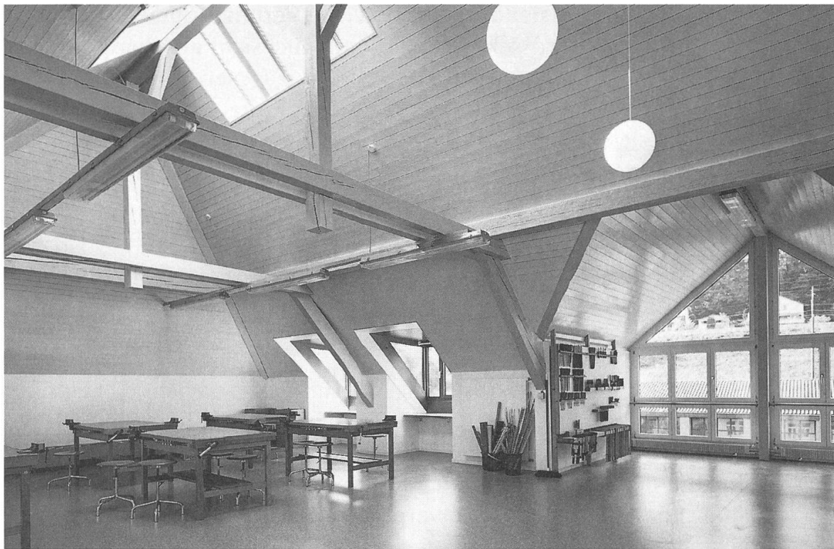
Der ausgebauter Dachraum mit zusätzlichen Lukarnen und mit First-Oberlicht. Vorbereitet als Klassenzimmer, wird er gegenwärtig als Werkraum benützt.
