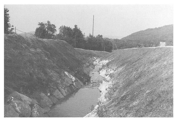
Schinznach-Dorf/Wisstrotten, Frühsommer 1989 – Der Längebach ist verlegt, der Autobahnbau entlang der linken Uferböschung beginnt. Das baumhohe Ufergehölz des bisher von links kommenden alten Bachlaufs muss weichen. Da das neue Gerinne hier nicht in gewachsenem, sondern ausgetauschtem Boden verläuft, ist der Böschungsfuss mit Steinsatz und Weiden-Steckhölzern vor Nachrutschungen gesichert. (Foto: André Seippel)
