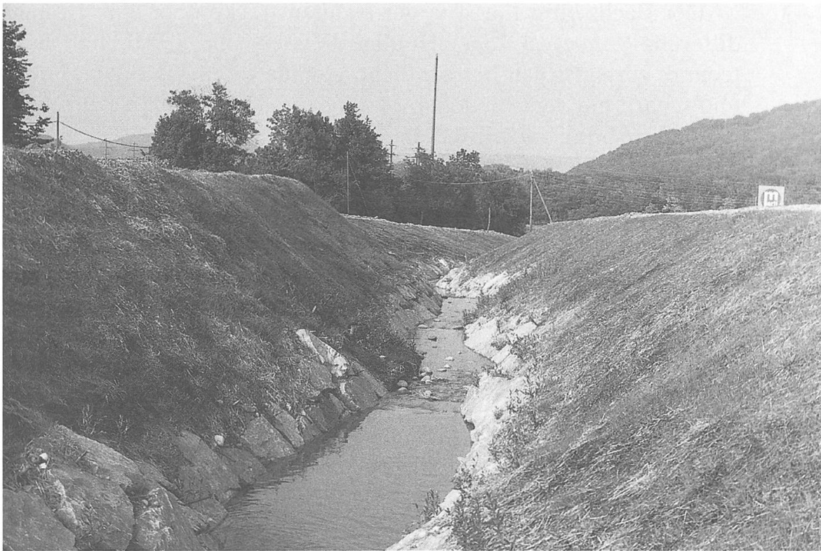
Schinznach-Dorf/Wisstrotten, Frühsommer 1989 – Der Längbach ist verlegt, der Autobahnbau entlang der linken Uferböschung beginnt. Das baumhohe Ufergehölz des bisher von links kommenden alten Bachlaufs muss weichen. Da das neue Gerinne hier nicht in gewachsenem, sondern ausgetauschtem Boden verläuft, ist der Böschungsfuss mit Steinsatz und Weiden-Steckhölzern vor Nachrutschungen gesichert. (Foto: André Seippel)
