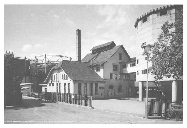
Das Gaswerk Brugg von Süden. Links vom Hauptgebäude sind die zwei heute abgebrochenen Gasbehälter, rechts schliesst die 1951 erbaute Kohlenaufbereitungsanlage an.
