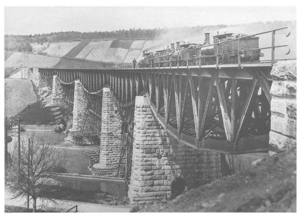
Die zweite Eisenbahnbrücke von 1905, wahrscheinlich während eines Belastungstests. Die Gerüste stehen teilweise noch.
