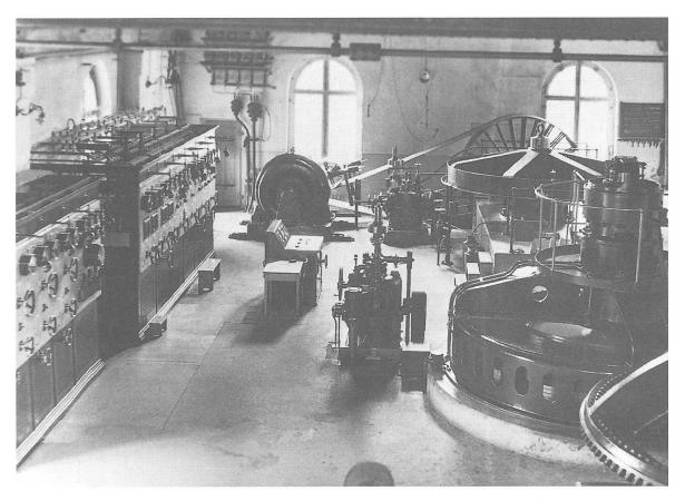
Innenraum des alten Kraftwerks 1936. Im Hintergrund drehte sich eine Francisturbine. Der Generator wurde über einen Riemen angetrieben. In der Mitte war die Propellerturbine, rechts das Kegelrad der dritten Turbine.
