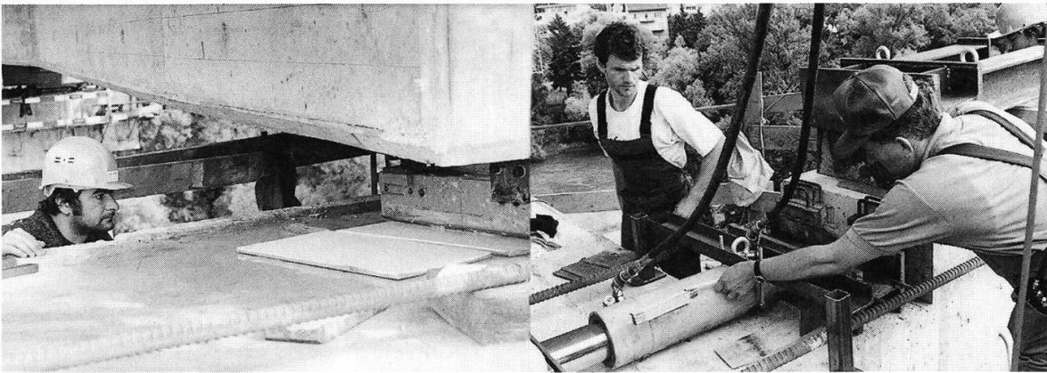
JULI 1995 – Mit Hydraulikpressen und auf Teflonplatten wird am 3. Juli die neue, 8500 Tonnen schwere Aare-Bahnbrücke zwischen Umiken und Brugg um 7 Meter in Richtung Endposition verschoben.
