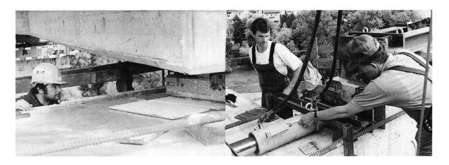
JULI 1995 – Mit Hydraulikpressen und auf Teflonplatten wird am 3. Juli die neue, 8500 Tonnen schwere Aare-Bahnbrücke zwischen Umiken und Brugg um 7 Meter in Richtung Endposition verschoben.
