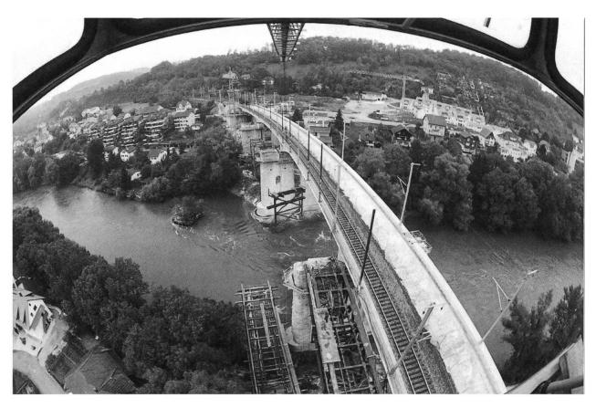
SEPTEMBER 1995 – Die alte Eisenbahnbrücke wird demontiert, und die rund 1700 Tonnen Stahl werden im luzernischen Stahlwerk Von Moos wieder eingeschmolzen.
