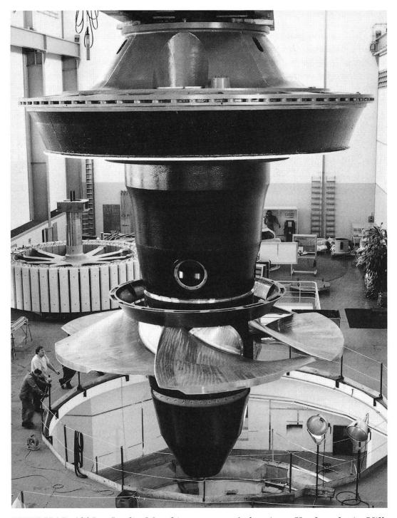
FEBRUAR 1995 – In die Maschinengruppe 1 des Aare-Kraftwerks in Villnachern wird das neue, 90 Tonnen schwere Kaplan-Turbinenlaufrad samt Oberteil und Turbinenwelle eingesetzt. Die Gesamterneuerung des Kraftwerks umfasst eine geschlossene Kühlung, die Erneuerung der Generator-Schaltanlage und der 110-Kilovolt-Schaltanlage sowie Rationalisierungsmassnahmen im Bereich der Betriebsführung.
