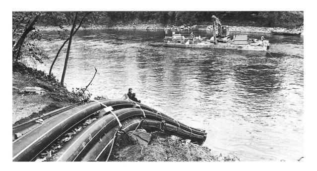
OKTOBER 1995 – In den Graben im Aaregrund werden die Kabelblöcke eingezogen. Die 16-Kilovolt-Leitung verbindet das neue AEW-Unterwerk Umiken mit der Trafostation Freudenstein der IBB und wird künftig Brugg mit Strom versorgen.
