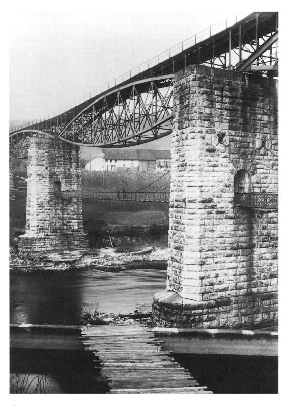
Überquerung des Oberwasserkanals des Brugger Kraftwerks mit einer einfachen Baubrücke aus Brettern: Vorbereitungen für das kommende Leergerüst. Im Hintergrund der Umiker «Schlüssel»
