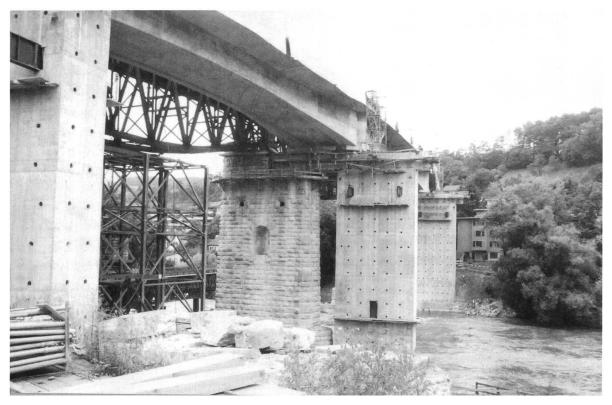
Position der neuen Brücke nach dem ersten Verschub von 7 Metern.
