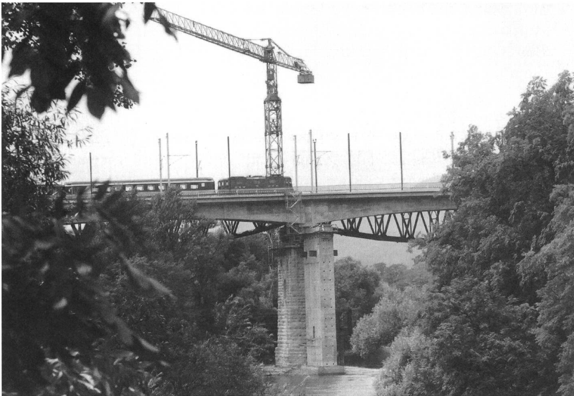
Die dritte Brückengeneration steht im Vordergrund auf Hilfspfeilern. Der neu zu bauende Fussgängersteg fehlt.
