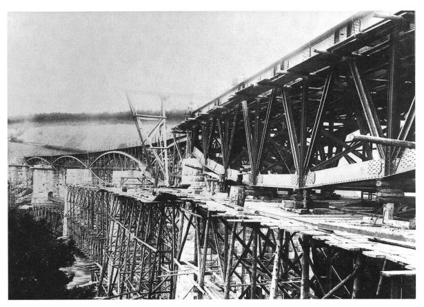
Aufwendiger Gerüstbau aus Holz und Eisen. Das erste Brückenelement auf der Brugger Seite ist fertiggestellt.
