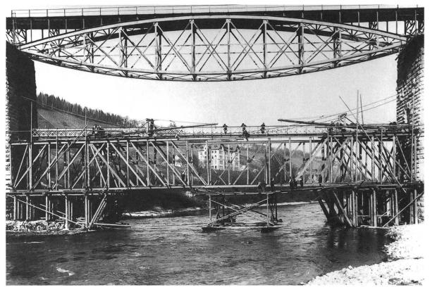
Gerüstbau über die mittlere Flussöffnung von 60 Metern.
