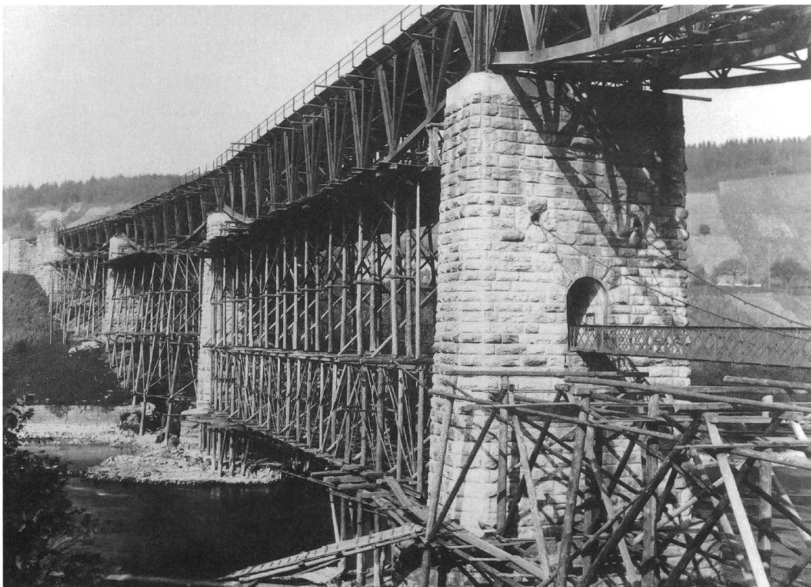
Die Halbparabelbrücke ist fertig. Auf der Brugger Seite wird bereits abgerüstet.
