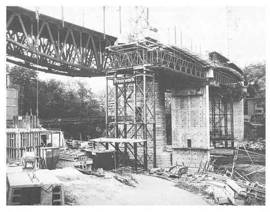
SEPTEMBER 1994 – Die neue SBB-Aarebrücke wird von der Umikerseite auf imposanten Hilfspfeilern vorangetrieben.
