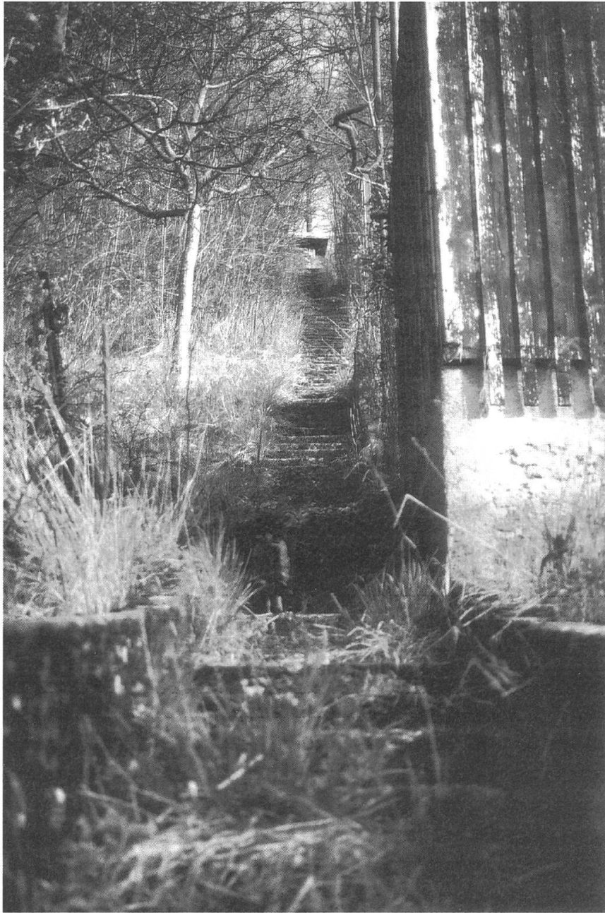
Eine noch sehr gut erhaltene Treppe führt den ganzen Berghang hinauf.
