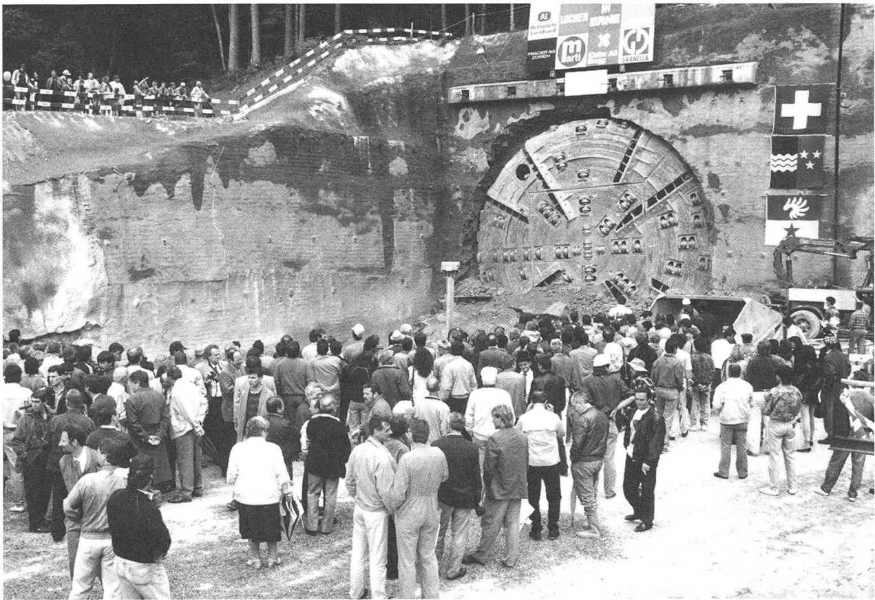
JUNI 1993 – Mit wiederum drei Monaten Vorsprung auf das Bauprogramm bricht am 4. Juni 1993 die riesige Tunnelbohrmaschine beim Bahnhof Effingen die zweite Röhre des Bözbergtunnels der N3 durch.
