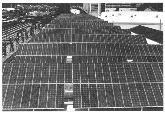
AUGUST 1992 – Mit 400 Quadratmetern Photovoltaikzellen und einer Leistung von 50000 kWh Strom pro Jahr ist die Solar-Anlage auf dem Dach der Fabrikhalle 5 der Kabel AG die grösste Anlage des Kantons. Die Anlage soll der Information und mit dem integrieten Messkonzept Aussagen zur effektiven Leistungsfähigkeit der Anlage liefern.
