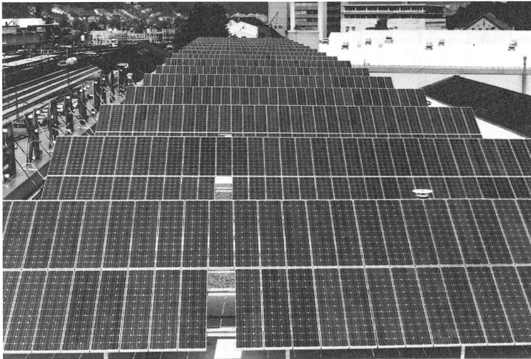
AUGUST 1992 – Mit 400 Quadratmetern Photovoltaikzellen und einer Leistung von 50 000 kWh Strom pro Jahr ist die Solar-Anlage auf dem Dach der Fabrikhalle 5 der Kabel AG die grösste Anlage des Kantons. Die Anlage soll der Information und mit dem integrierten Messkonzept Aussagen zur effektiven Leistungsfähigkeit der Anlage liefern. Foto: Infosolar, Brugg
