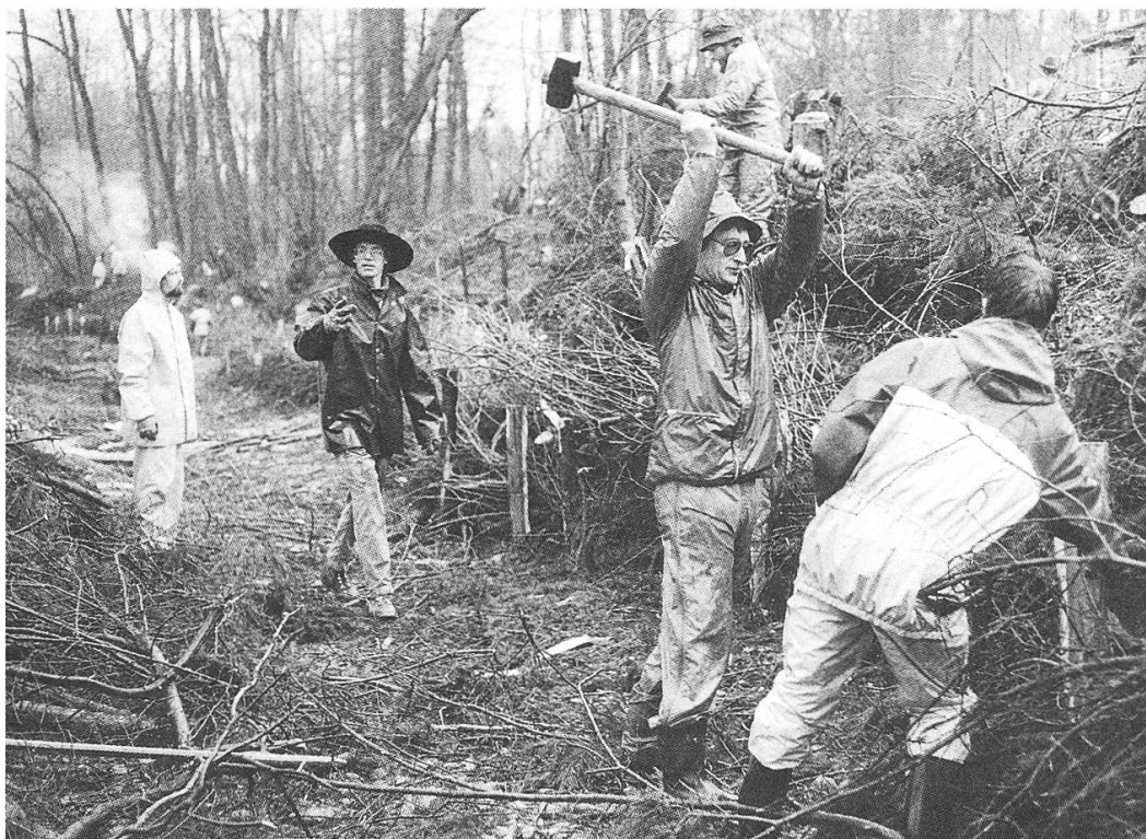
März 1988 – Im Windischer Aareschachen erstellen Mitglieder des Quartiervereins Unterdorf, der Gartenfreunde Sommerau und des Natur- und Vogelschutzvereins mit naturnahen Methoden einen Erosionsschutz des Ufers. (Badener Tagblatt)
